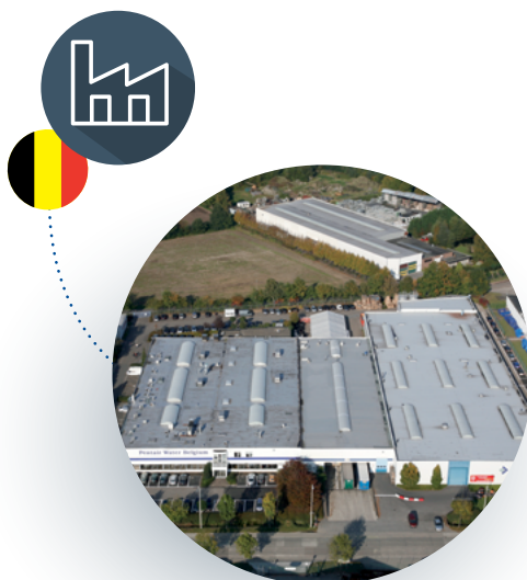
Site de production de Structural Herentals, Belgique
