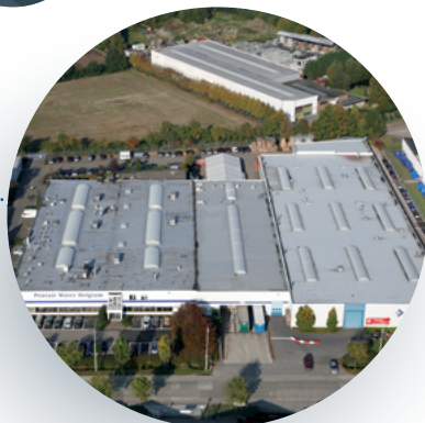
De productievestiging van Structural Herentals, België
